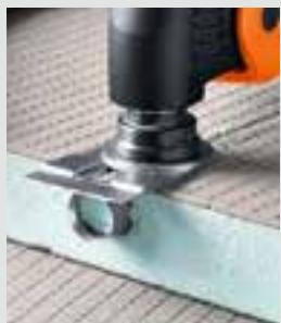
Výrezávání kanálů pro potrubí teplovodního podlahového topení.
