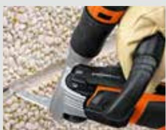
U nebezpečných spárovacích materiálů (např. PCB) se používá odsávání prachu.
