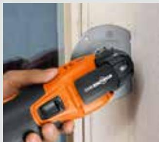
Protnutí kovových upevňovacích pásků při demontáži starých oken.
