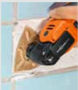
Rovinné obroušení lepidla na dlaždice před opětovným vyspárováním.
